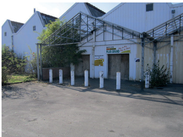
L'ancien Bricomarché à Caudry dans le cadre de l'opération "Rue Gustave Delory"
