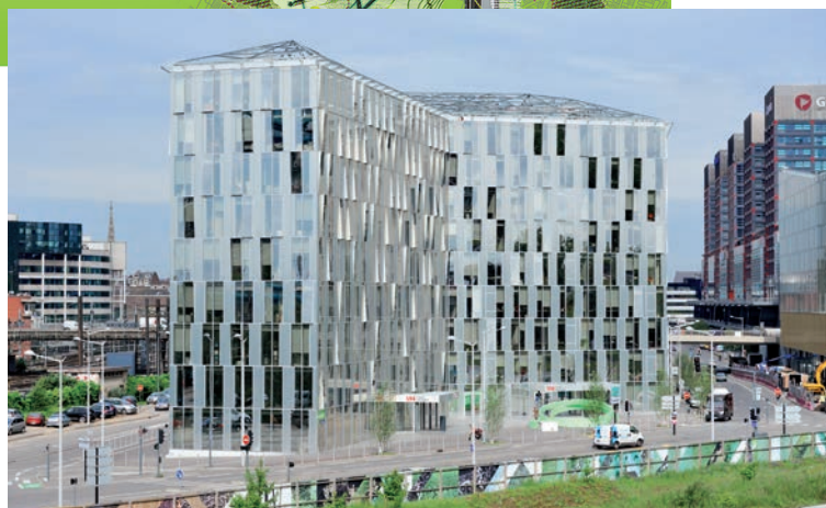
Le siège de l'EPF au sein du bâtiment de l'Onix
